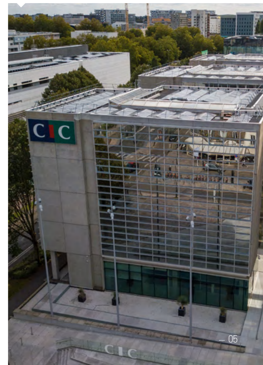
Siège du CIC Ouest à Nantes sur lequel 571 m 2 de panneaux photovoltaïques ont été installés en 2020.
